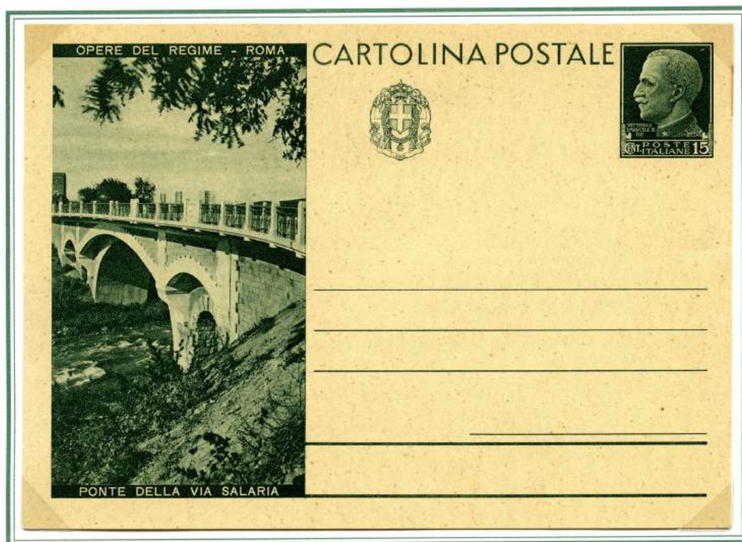
PONTE DELLA VIA SALARIA
