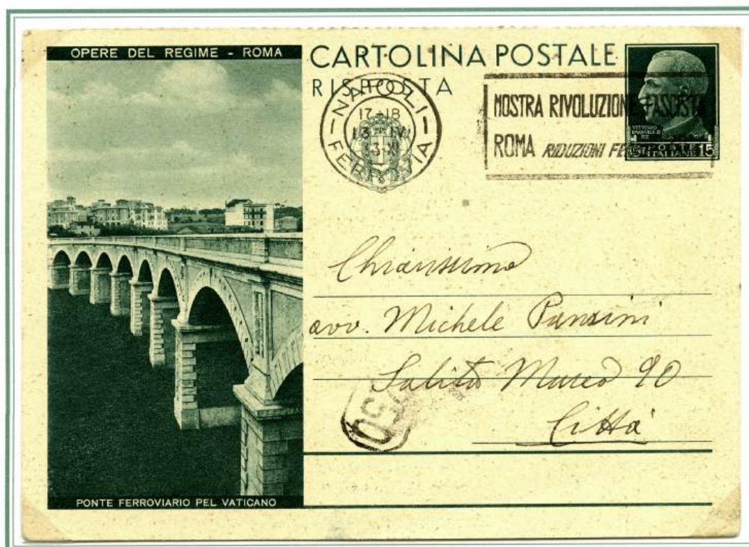
PONTE FERROVIARIO PEL VATICANO - 13.4.1933 - da Napoli per distretto.
