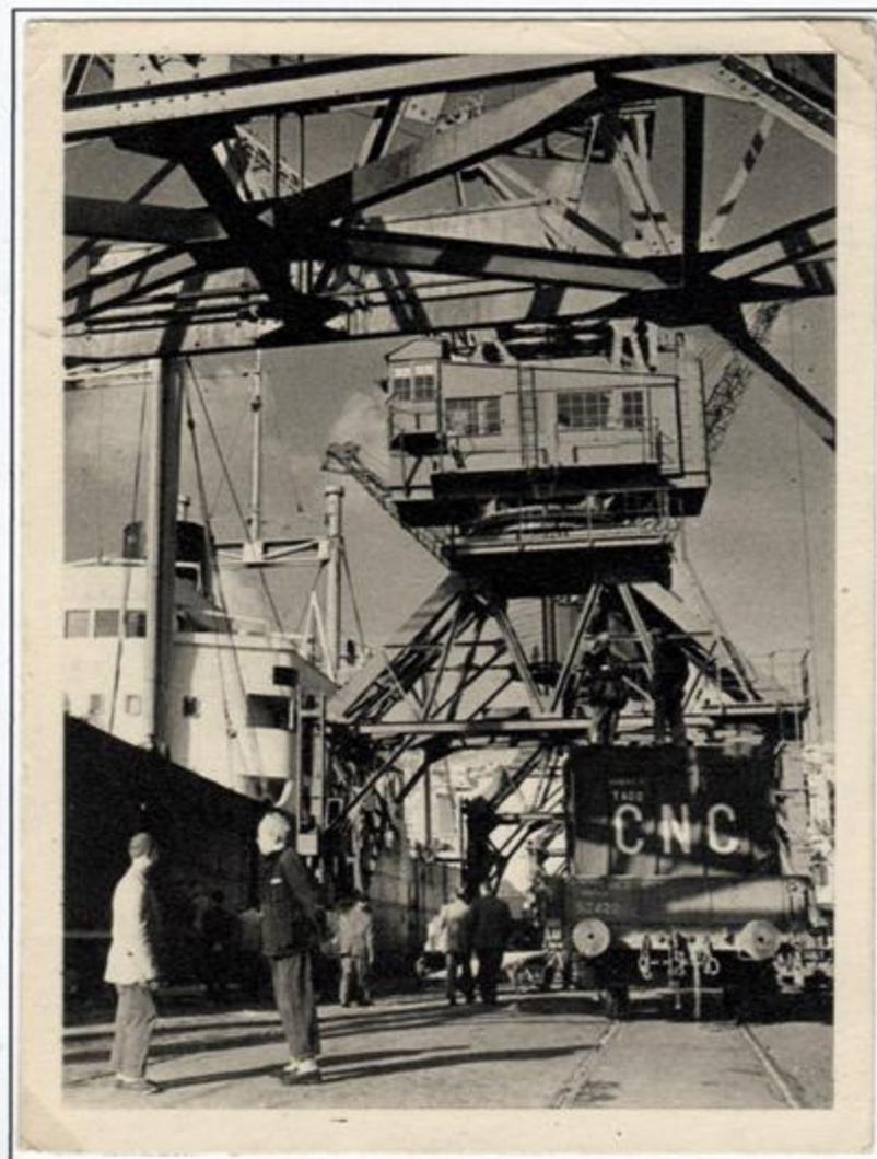
Le gru mobili a loro volta si dividono in due gruppi: gru a portico, con base scorrevole su binari costituita da una incastellatura a forma di U rovesciata ( $\Pi$ ) che permette il passaggio di almeno un vagone ferroviario o di un camion .....
