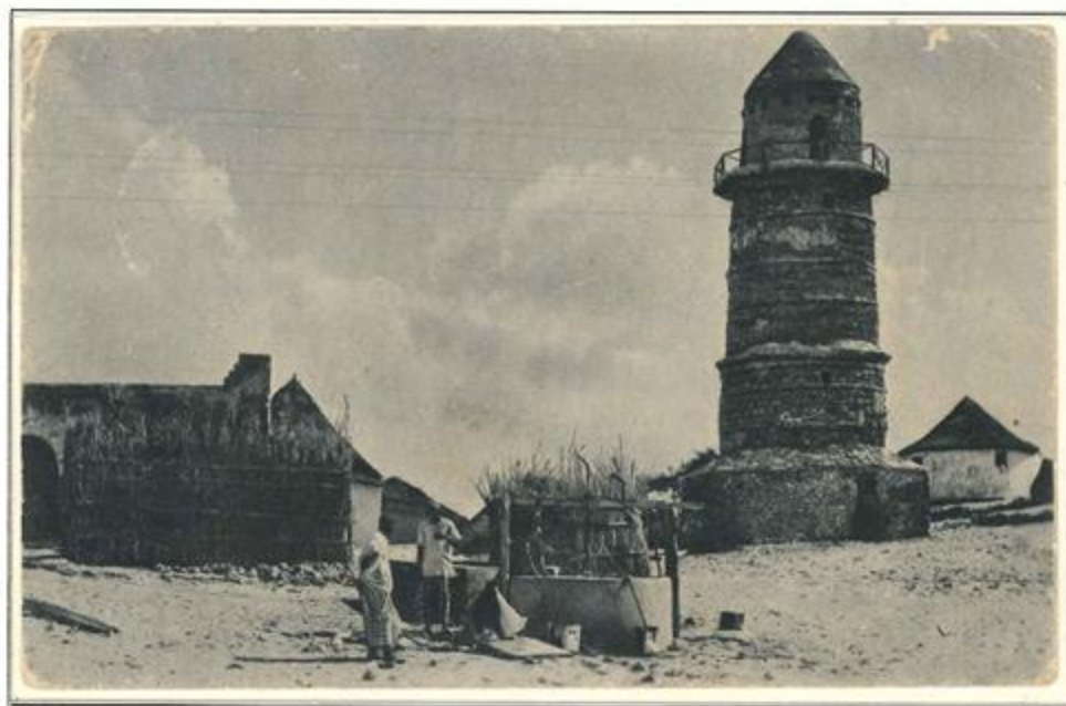
Torre Mnara a Mogadiscio: antico faro di costruzione araba del secolo XII
