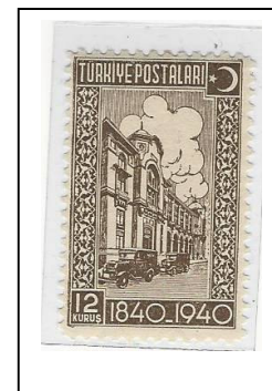
Palazzo delle Poste
