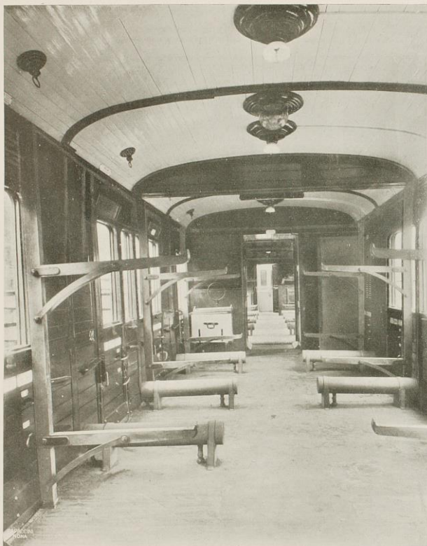
Carrozze di III classe a carrelli, Serie C/2 tipo 1910 ridotte ad uso « Infermeria per 24 infermi, in due Riparti ». Carrozze n. 5 a 11 del treno. Interno, dimostrante la disposizione dei montanti porta-barelle.
