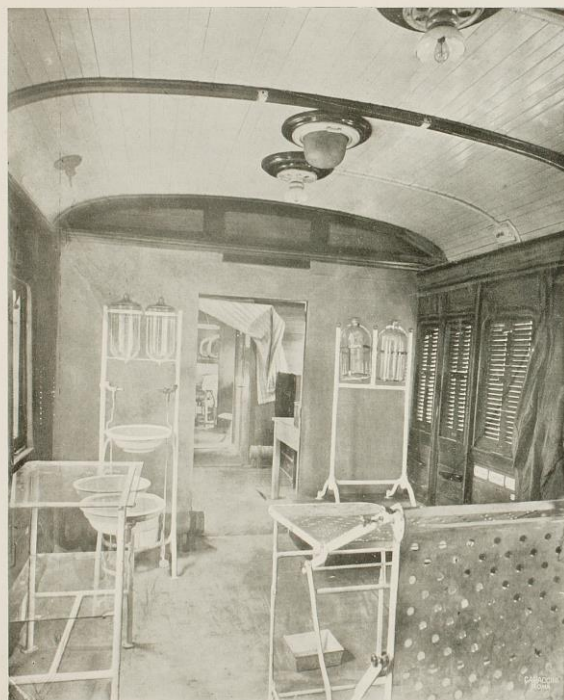
Carrozza di III Classe a carrelli. Serie C/2 tipo 1910 ridotta ad uso «Sala di medicazione, Farmacia e Riparto per 12 infermi». Carrozza N. 12 del treno. Interno della sala di medicazione.
