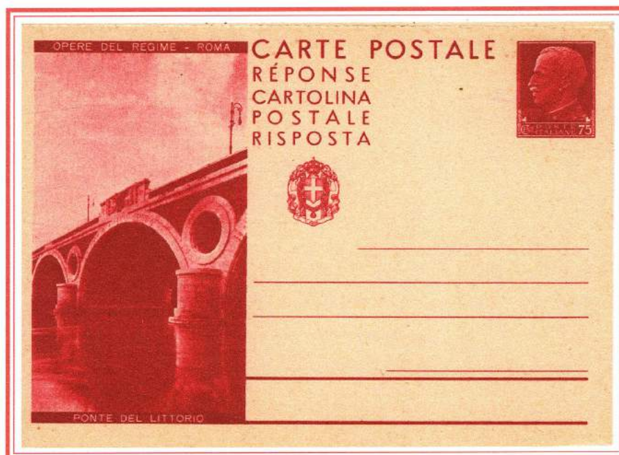
R (PONTE DEL LITTORIO)
