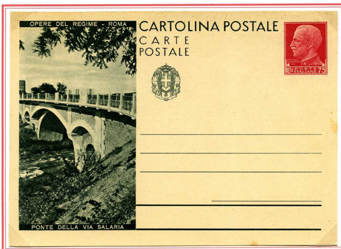
(PONTE DELLA VIA SALARIA)
