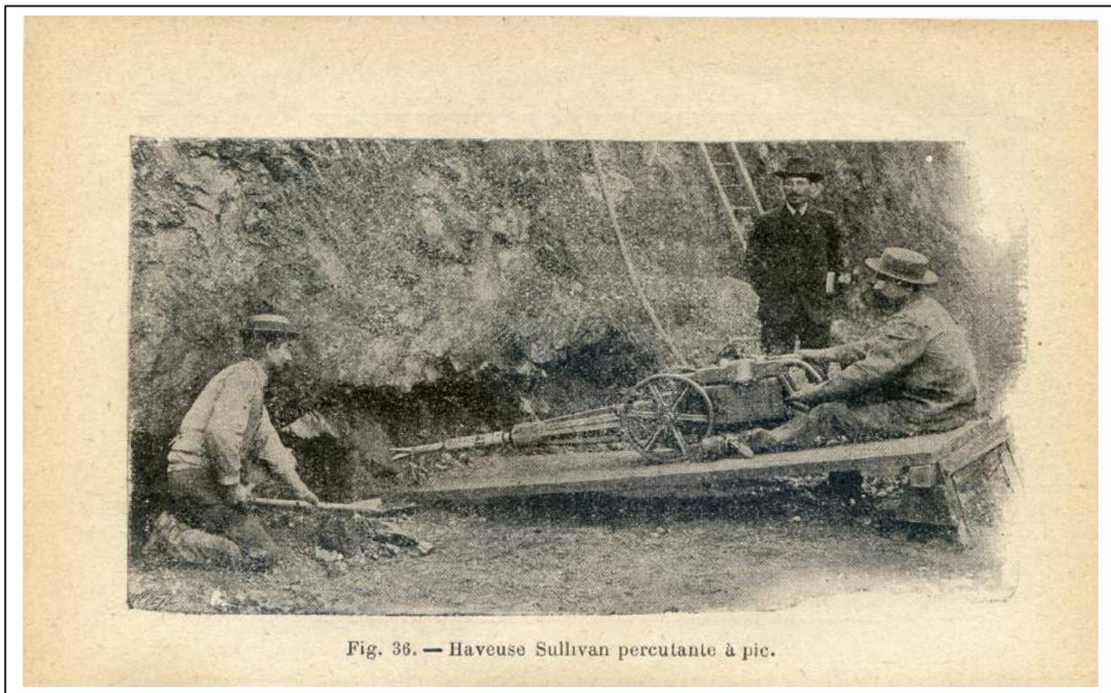
Fig. 36. — Haveuse Sullivan percutante à pic.
