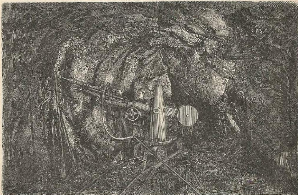
3. Stofsende Bohrmaschine mit Druckluftbetrieb im Rammelsberge bei Goslar.
