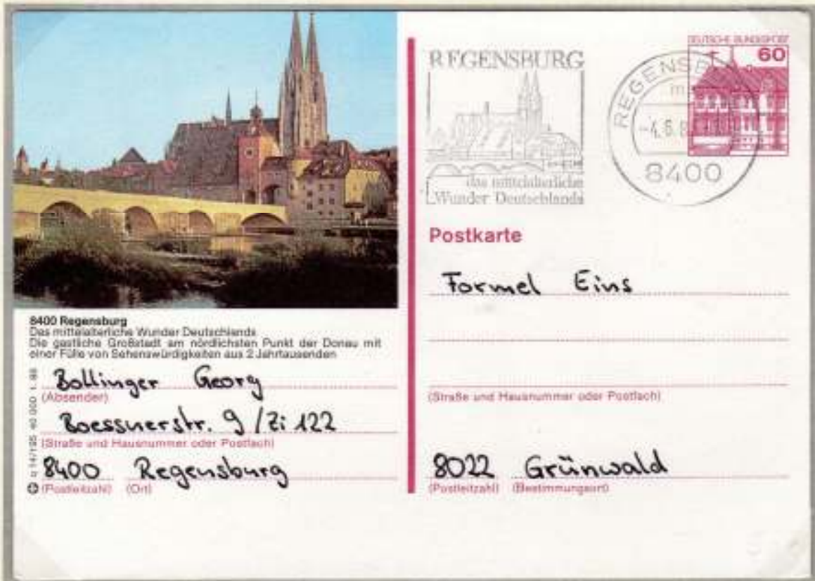
Die Steinerne Brücke zu Regensburg (D) über die Donau, erbaut 1135 – 1146. Die Bogenform wurde von den Römern übernommen. Die Spannweiten betragen zwischen 10,4 und 16,7 m. Heute 15 Bögen sichtbar. Bildpostkarte .
