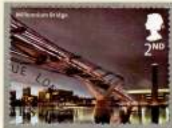
Milleniumsbrücke in London (GB), Baujahr 2000, umfangreiche Sanierungsmassnahmen gleich nach Inbetriebnahme, da die Brücke infolge Fussgängerverkehr zu hohe seitliche Schwingungen ausführte. Teure Sanierung mit Dämpfern.
