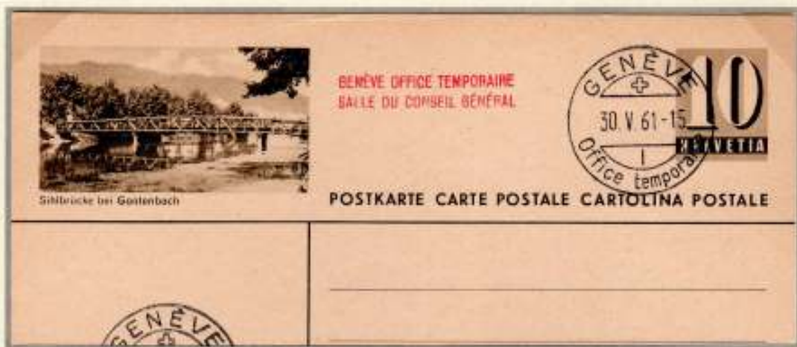
Stirnemannsteg über die Sihl. Gontenbach gehört zur Gemeinde Langnau a. A. (CH). Erwin Stirnemann (1885 1970) war Vorsteher des Tiefbauamtes des Kantons Zürich. Die alte Stahlkonstruktion, welche die Wege beidseits der Sihl (Sihlufertweg) verband, wurde im Jahre 2008 ersetzt.
