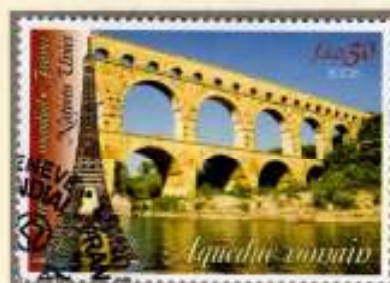
Pont du Gard (F). Diese 49m hohe und 273m lange Brücke in Mauerwerk gehört zu der rund 50 km langen Wasserleitung, die um 15 v. Chr. G. von den Römern unter Agrippa erbaut wurde, um gutes Quellwasser aus der Gegend von Uzès nach Nîmes zu leiten.
