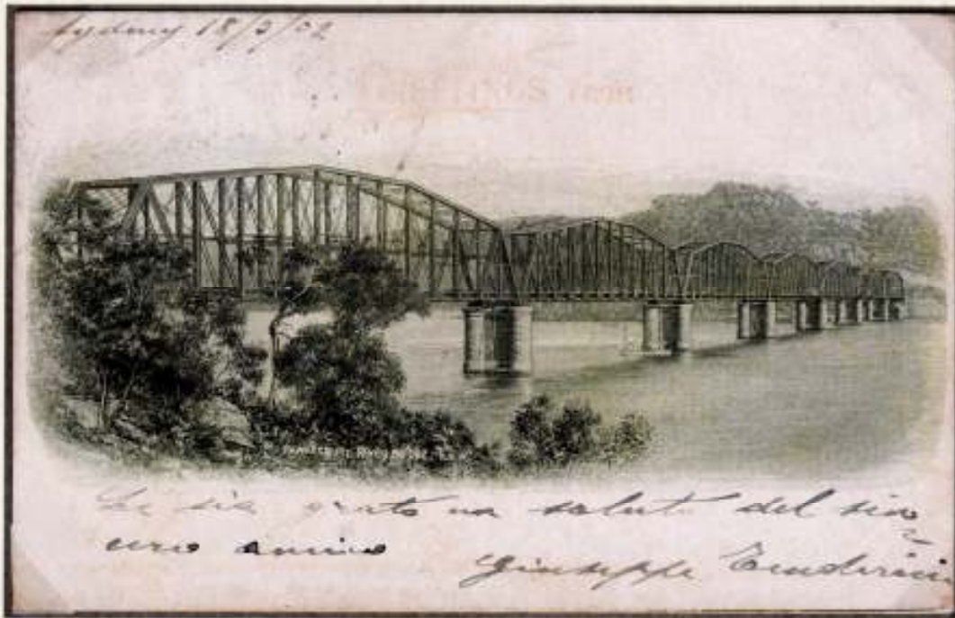
Hawkesbury Bridge (NSW, Australien) , engl. Bahnbrücke 1886/89, 7 Spannweiten zu 416 Fuss (126.8 m), ersetzt 1946
