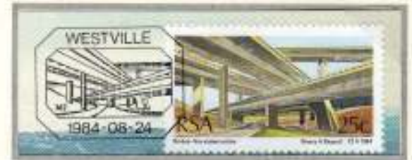
Vierstöckiges Kreuzungsbauwerk in Westville bei Durban, Südafrika, Pfeiler bis 30 m hoch.
