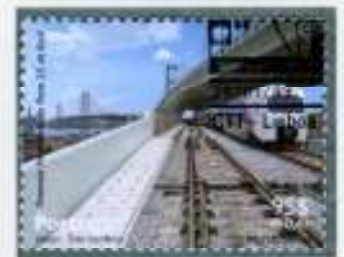
Die Bahn im Innern eines Fachwerkträgers in Stahl. Ponte 25 de Abril (P) , über den Tejo bei Lissabon. Baujahr 1966.
