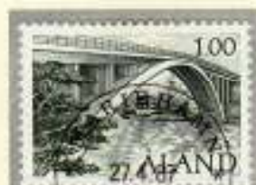
Färjsund-Brücke, 1937, Åland, Spannweite 130 m
