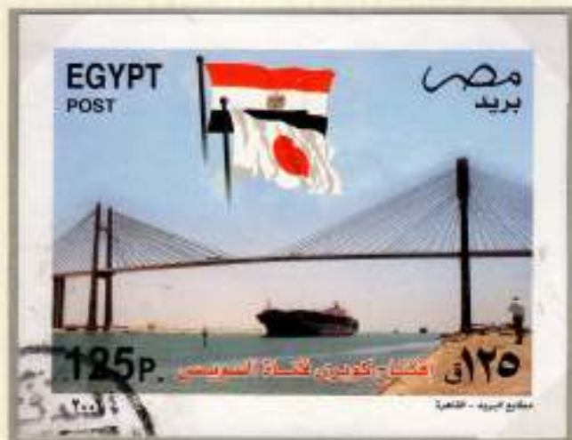
Block + Briefmarken oben rechts: Mubarak-Peace Bridge Egypt/Japan über den Suezkanal, 1997-2001, Spannweite der Mittelöffnung 404 m, Durchfahrtshöhe 70 m ! Unten rechts: Aswan Bridge über den Nil, 1996-2002, Mittelöffnung 250 m.
