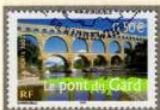
Pont du Gard (F). Diese 49m hohe und 273m lange Brücke in Mauerwerk gehört zu der rund 50 km langen Wasserleitung, die um 15 v. Chr. G. von den Römern unter Agrippa erbaut wurde, um gutes Quellwasser aus der Gegend von Uzès nach Nîmes zu leiten.
