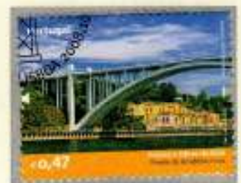
Ponte da Arrabida (P), 1963, Spannweite 270 m, Ing. E. Cardoso
