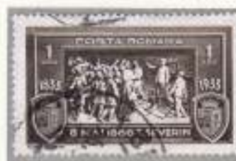
Brücke im Wappen von Turnu Severin, Trajansbrücke, Donaubrücke
