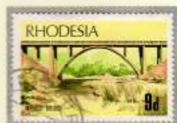
Mpudzi River Bridge, 1961, Rhodesien, Spannweite 30,5 m
