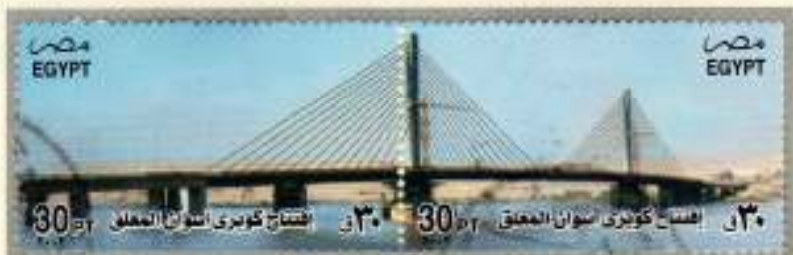
Block + Briefmarken oben rechts: Mubarak-Peace Bridge Egypt/Japan über den Suezkanal, 1997-2001, Spannweite der Mittelöffnung 404 m, Durchfahrtshöhe 70 m ! Unten rechts: Aswan Bridge über den Nil, 1996-2002, Mittelöffnung 250 m.
