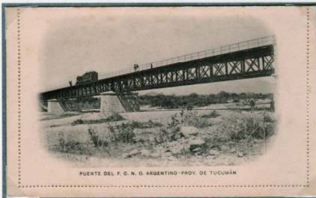
Argentinische Ganzsache, um 1900. Zugskomposition auf Durchlaufträger, Parallelfachwerk mit St. Andreas-Kreuzen. Auf der Gotthardstrecke (CH) hatten viele Bahnbrücken der 1. Generation das gleiche statische System wie die oben dargestellte Bahnbrücke in Argentinien.
