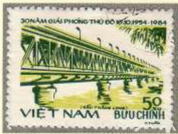
Durchlaufender Parallelträger, Stahl, Strebenfachwerk mit Pfosten, Strassenbrücke Thang Long in Hanoi, Vietnam.
