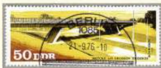
Spannbetonbrücke am Grossen Dreesch bei Schwerin (D) mit Stützweiten von 28 m – 45 m – 28 m.
