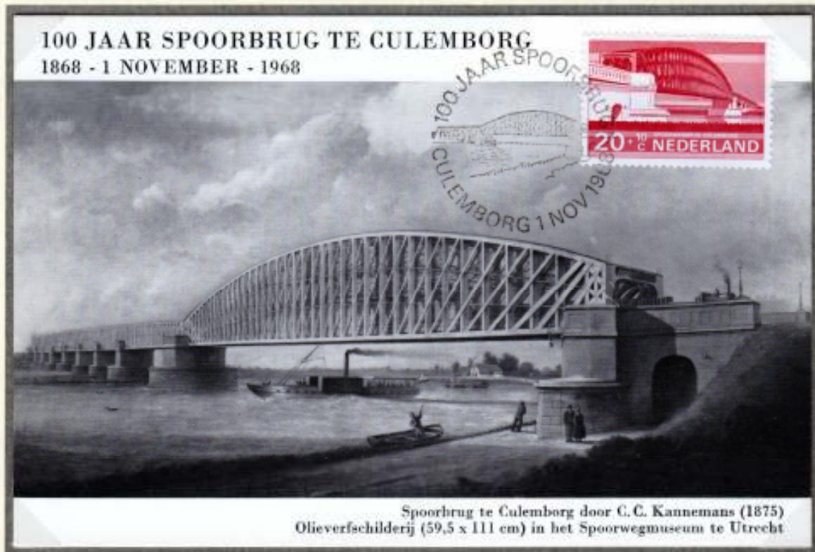
Die Eisenbahnbrücke über den Lek bei Culemborg (NL), Strecke Utrecht – S'Hertogenbosch, von 1868 bis 1983 in Betrieb, Spannweite 154,4 m, Gewicht Stahl rund 2500 t. Dreifaches Ständerfachwerk. Ingenieur: Gerrit van Diesen. Anschlussbauwerk: 1 x 83,5 m + 7 x 59,5 m. Maximumkarte.
