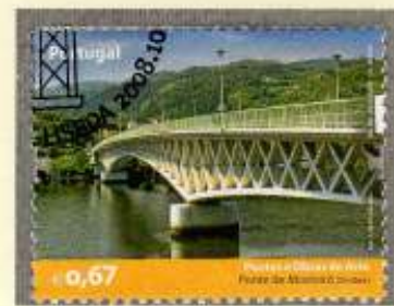
Durchlaufender Fachwerkträger in Beton, mit Vouten
