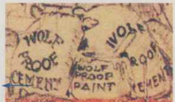
Détail des sacs de ciment
