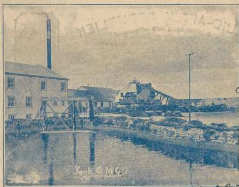
Ganzsache (Südafrika) - Cyanidbecken auf einem Goldminengelände um 1899. Das Edelmetall findet sich chemisch gebunden im hochgiftigen Sickerwasser. Nach Filtration und Ausfällung mit Zinkstaub erhält man es als braunen Schlamm, aus dem nach Waschen und Trocknen, durch Reduktion Rohgold wird.
